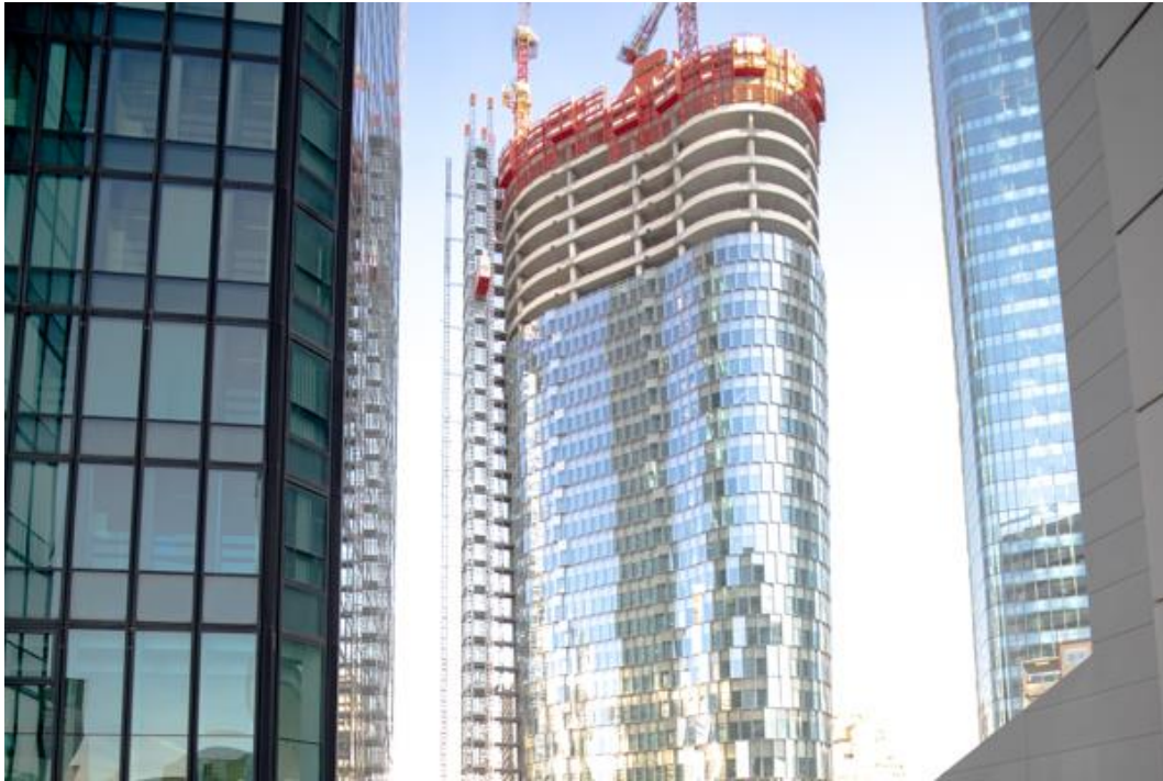
La tour Alto, en construction à La Défense. © Jgp
